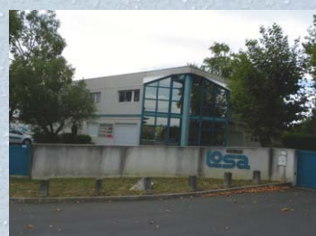
LOSA ELECTRICITÉ - BIARRITZ
