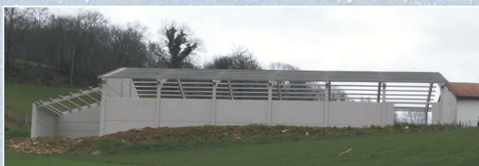
ENTREPÔT AGRO-INDUSTRIEL. LASSE
