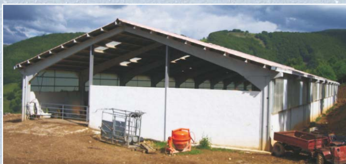
ENTREPÔT AGRO-INDUSTRIEL. ARNEGUY
